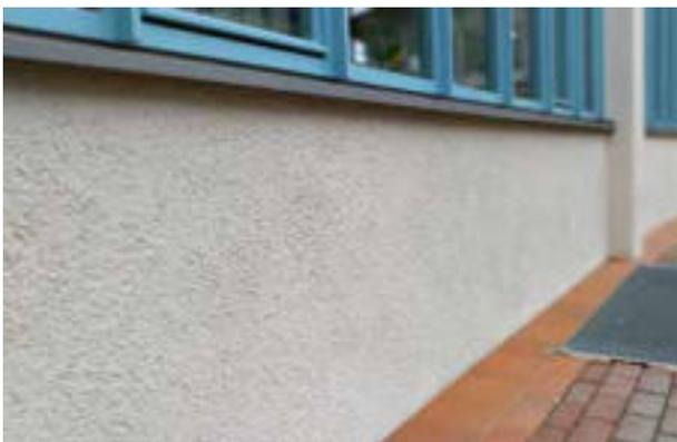
Armierungsschicht und Oberputz einschließlich Anstrichsystem wurden erneuert (Abb. 11 - 13). Hierfür wurde der Untergrund gemäß DIN 18350 mittels Wischprobe, Benetzungsprobe, Ausloten usw. auf Art, Eignung, Unebenheiten, Trag- und Haftfähigkeiten geprüft. Zur Egalisierung der Saugfähigkeit des Untergrundes wurde eine transparent-wässrige Grundierung mit haftvermittelnder Wirkung aufgebracht.
